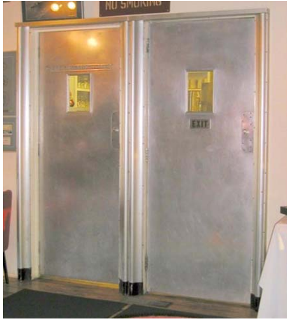
Abb. 27–9 Wie diese Türen zu öffnen sind, ist intuitiv erfassbar und eindeutig, weil die Form des »Türgriffs« der Funktionsweise des Öffnungsmechanismus angepasst ist.
